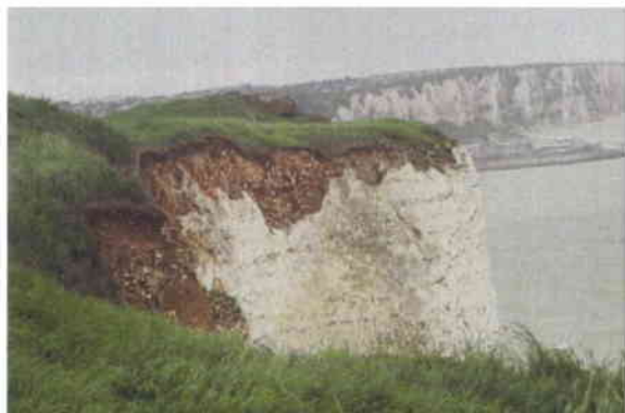
Poches d'argiles à silex au sommet de la craie résultant d'un phénomène de karstification (Photo : P.Dron)
